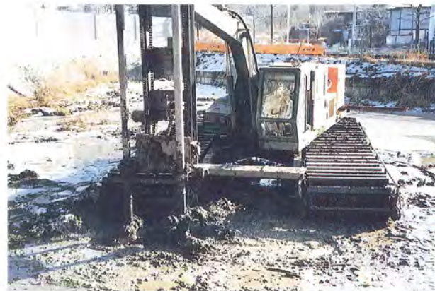
地盤改良工事
