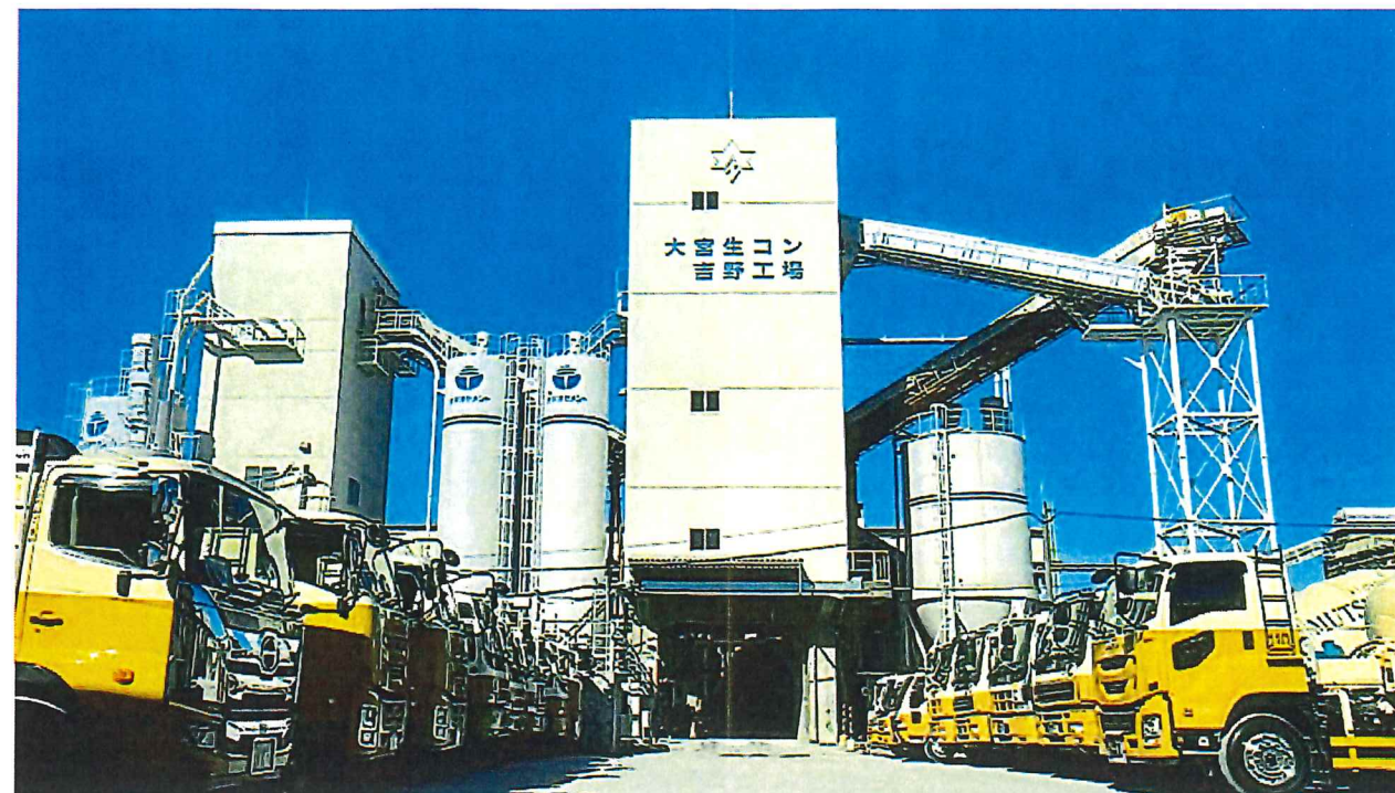
生コンクリート製造プラント
