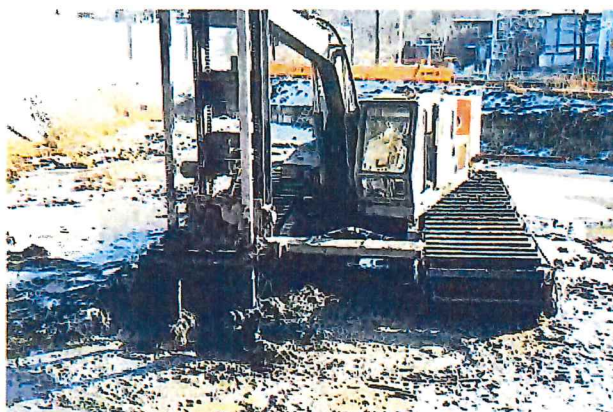
地盤改良工事
